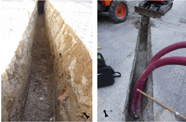
A l'esquerra imatge de detall de la rasa 9. A la dreta imatge final de la rasa i cobriment.
