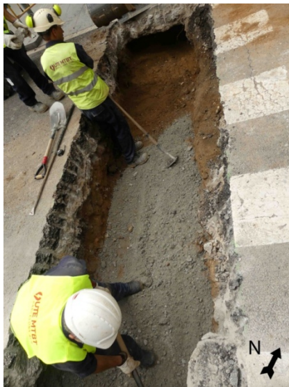
Procés d'excavació de la meitat sud de la rasa 2 i cobriment.
