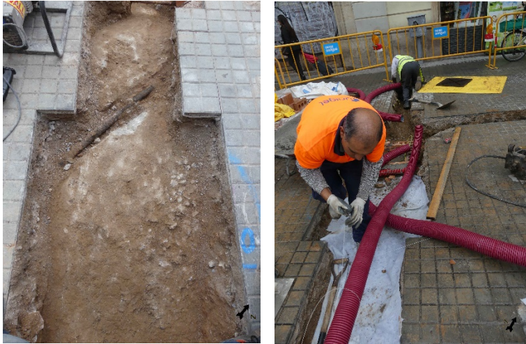
A l'esquerra imatge de detall de la volta del metro. A la dreta imatge del procés de cobriment.
