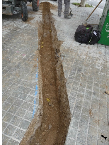
Imatges de procés d'excavació dels diferents trams de la rasa.
