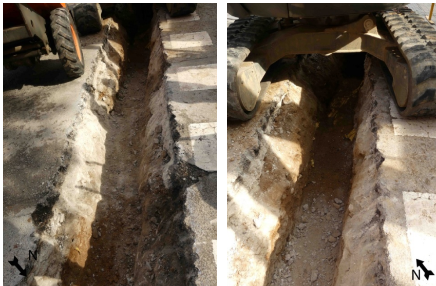
Procés d'excavació de la meitat est de la rasa3.
