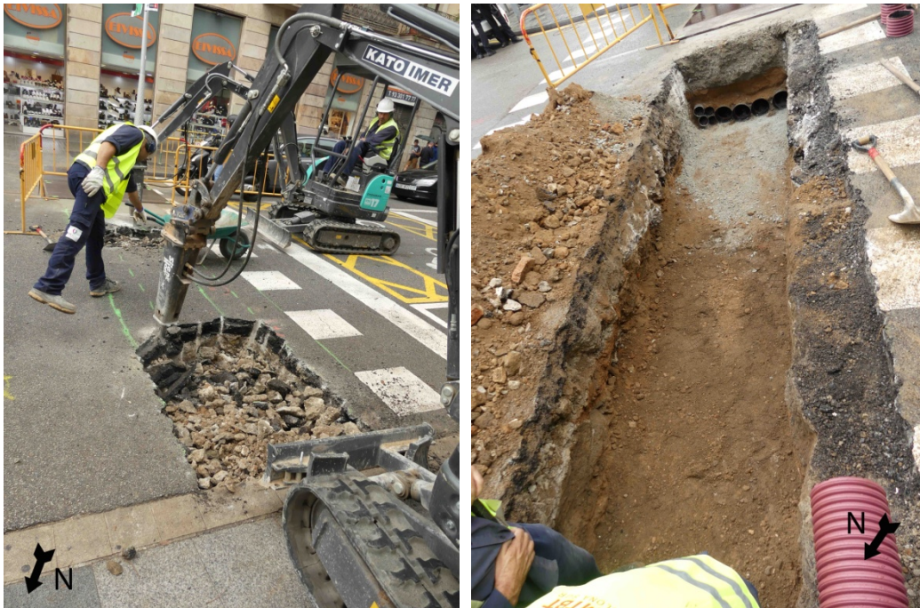
Procés d'excavació de la meitat nord de la rasa 2.
