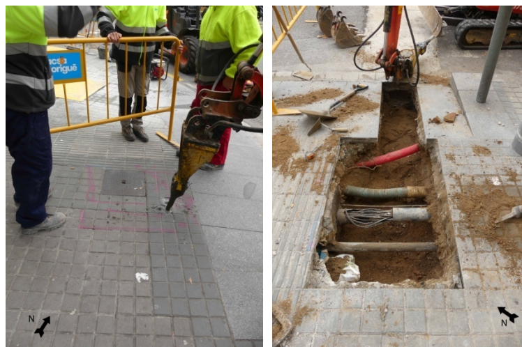
A l'esquerra imatge inicial de la rasa 9. A la dreta imatge final.
