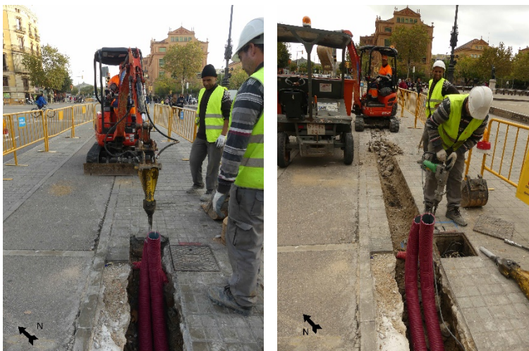
A l'esquerra imatge inicial de la rasa 10. A la dreta imatge de procés d'excavació de la rasa.
