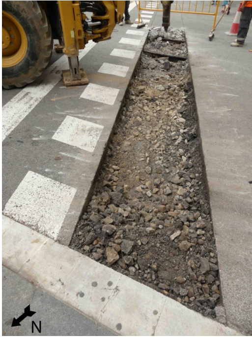
Imatge del procés de l'excavació i troballa d'una via de tramvia contemporània i actual.
