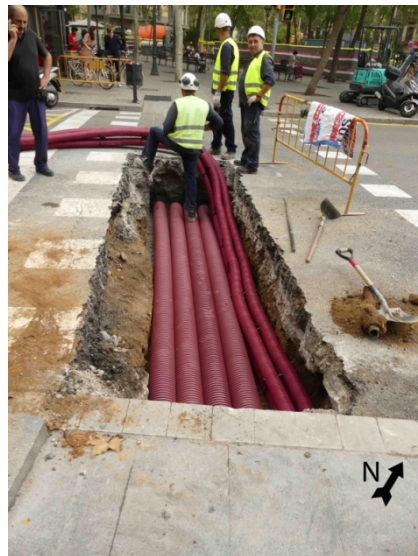
Procés d'excavació de la meitat sud de la rasa 2 i cobriment.
