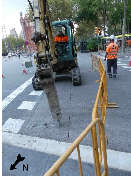
Imatge inicial de l'excavació de la rasa. Vista des del nord.
