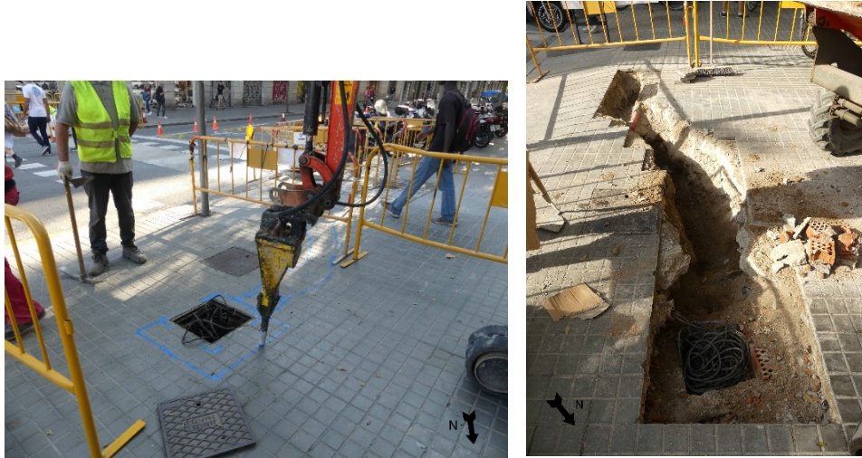
A l'esquerra imatge inicial de la rasa 8. A la dreta imatge final.
