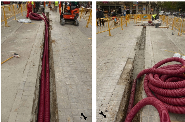
A l'esquerra, imatge del cobriment amb corrugat. A la dreta, procés de cobriment amb ciment del tub.
