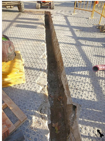
A l'esquerra procés d'excavació de la rasa 9. A la dreta imatge final de la rasa.
