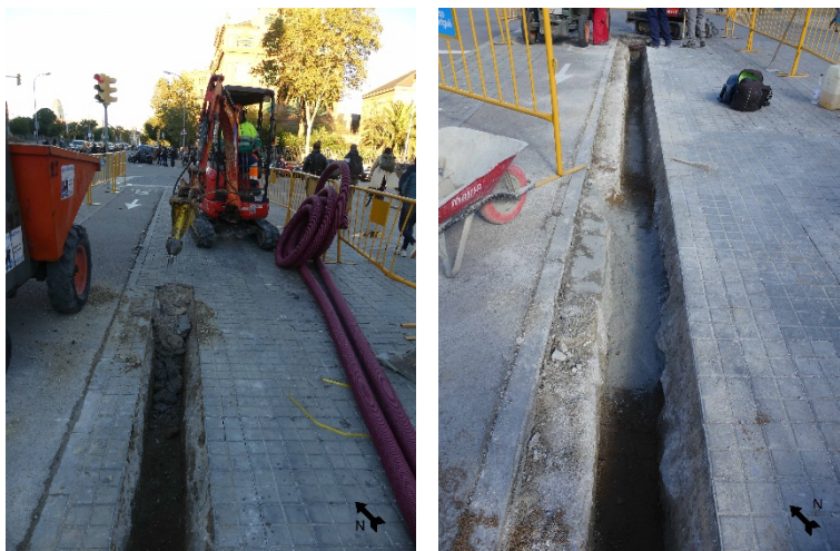
Imatges de procés d'excavació dels diferents trams de la rasa.
