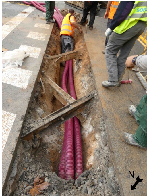
Imatge del procés de cobriment de la rasa.
