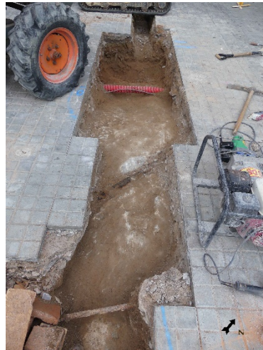
A l'esquerra procés d'excavació del tram restant de la rasa. A la dreta, imatge de la rasa ja oberta.
