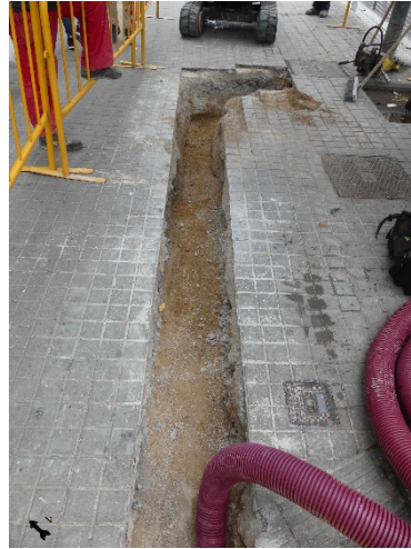
Imatges de procés d'excavació dels diferents trams de la rasa.
