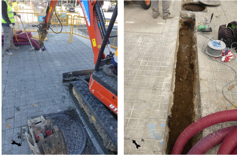
Imatges de procés d'excavació del tram final de la rasa.
