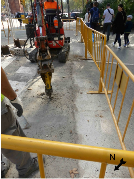
Imatges del procés d'excavació de l'últim tram de la rasa més al sud.
