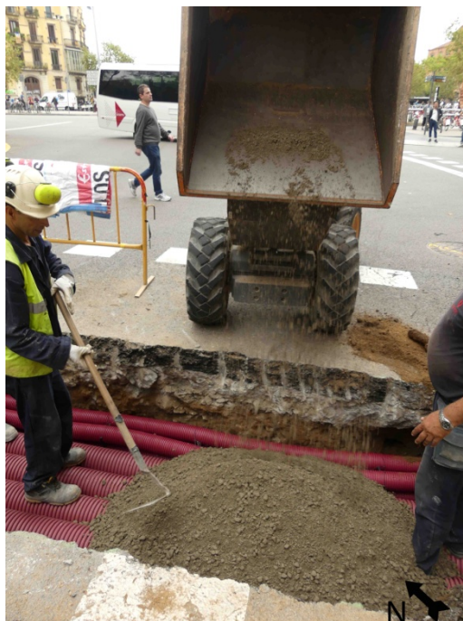
Procés de cobriment de la meitat nord de la rasa 2.
