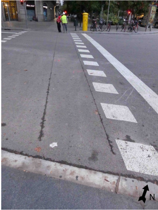
Imatge inicial de l'excavació de la rasa. Vista des del sud.
